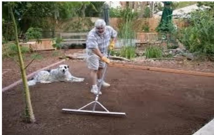
*Figura 6: Nivelamento do solo*
